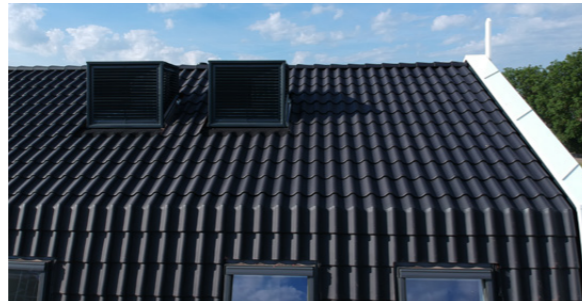
Dakopstelling Breman Schoorsteentechniek
