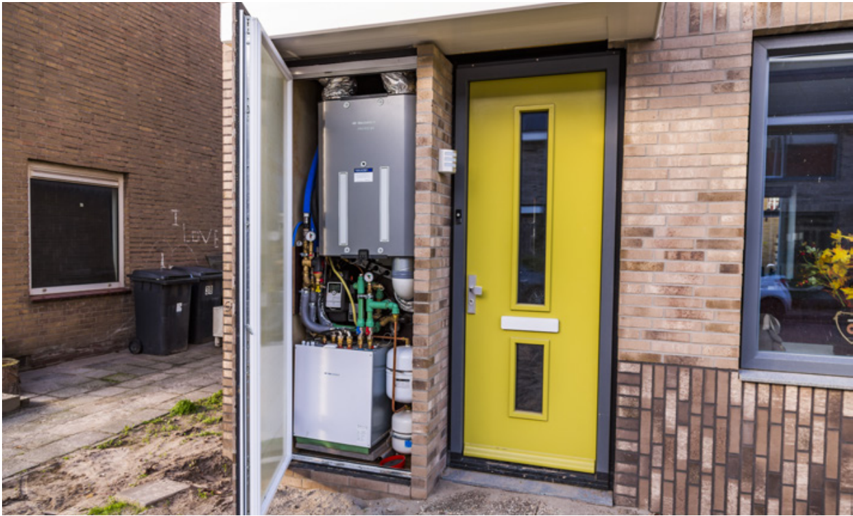
In de gevel geïntegreerde energiemodule t.b.v projectmatige NOM renovaties van Hazenberg Bouw.
